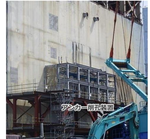
アンカー削孔装置（2022年4月時点）
