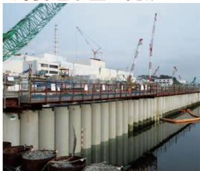
1～4号機の敷地から港湾内に流れている地下水をせき止め、海洋汚染を防止するため、2012年4月より工事を開始。2015年10月海側遮水壁が完成。
