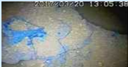
ペDESTAL※ 3 外側の状況
