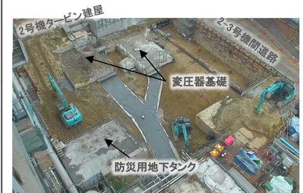
2号機原子炉建屋南側ヤード状況
