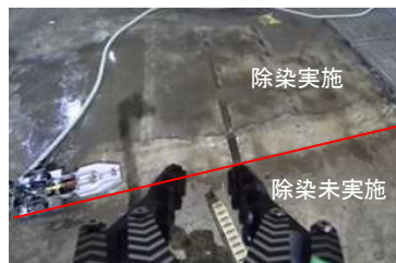
床面の高圧水除染状況
