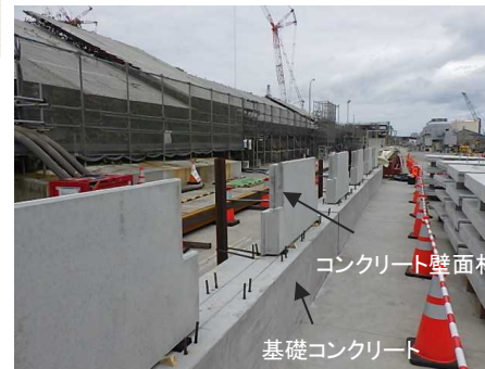
コンクリート壁面材設置状況
