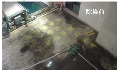
オペフロ南西部の除染状況
