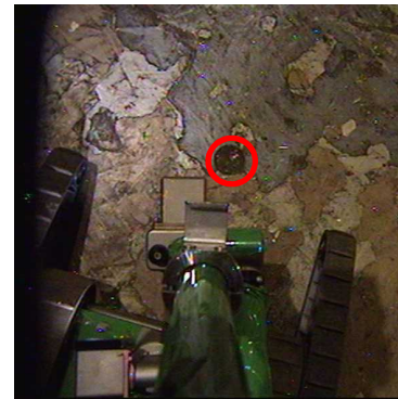
部拡大現場状況
