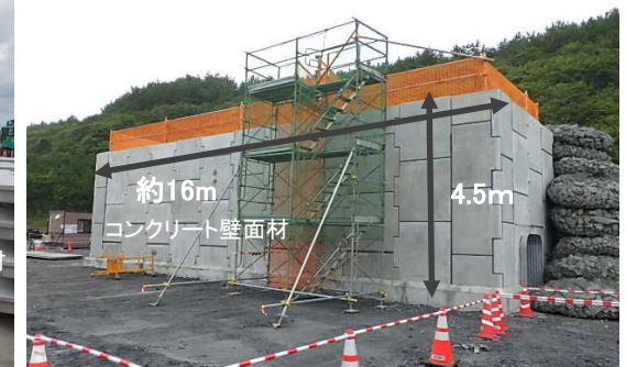
コンクリート壁面材の試験施工状況
