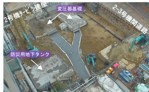
2号機原子炉建屋南側ヤード状況
