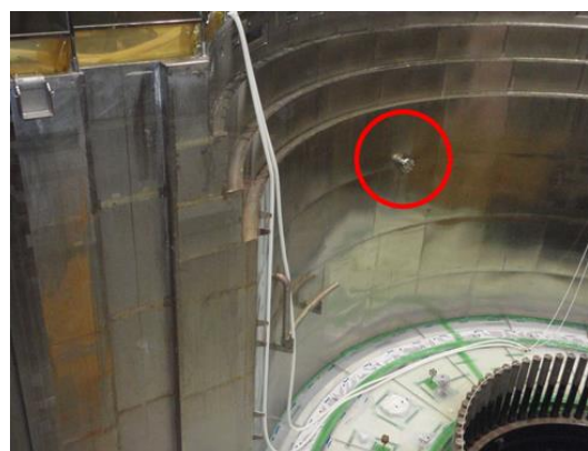
1号機 ウェル除染風景(事故前の定検中)
