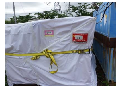
養生・線量表示実施後のコンテナ
