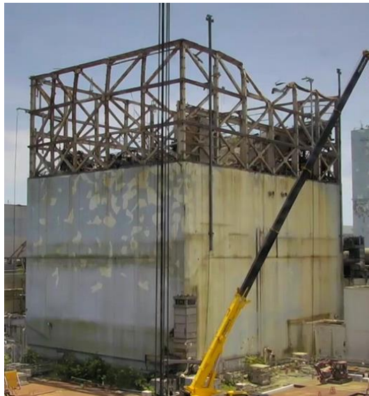
1号機原子炉建屋全景 (2021年6月3日時点)
