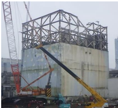
1号機原子炉建屋全景
