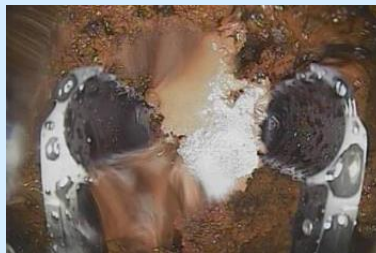
ペDESTAL※ 3 内堆積物の把持状況
