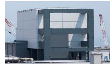
原子炉建屋外観
