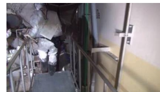
建屋内有人調査 (1号機3階使用済燃料プール壁 2014年2月)
