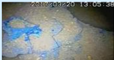
ペDESTAL※ 3 外側の状況
