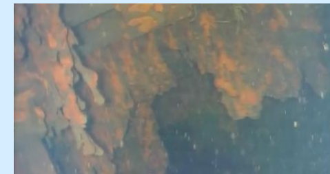
ペDESTAL※ 3 内側の状況
