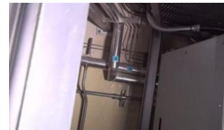
建屋内有人調査 (1号機3階シェル壁 2014年2月)
