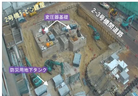
2号機原子炉建屋南側ヤード状況
