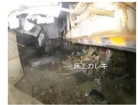
3階プール壁とハッチ開口の間
