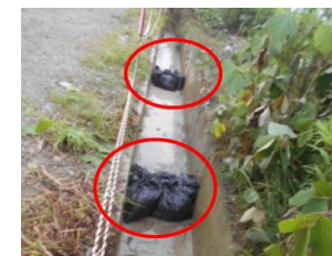
排水溝にゼオライト土嚢※1設置
