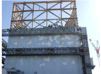
1号機原子炉建屋 点検写真例(北側)
