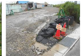
ゼオライト土嚢※1設置
