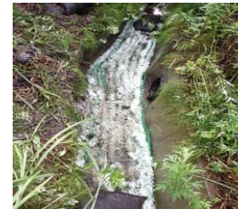
ストロンチウム除去材とゼオライト土嚢※1設置
