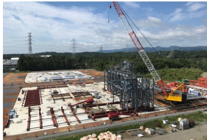
構外ヤード全景 (2021年6月21日時点)
