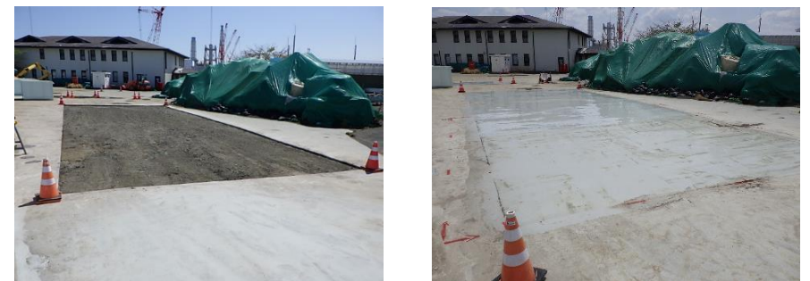
⑤アスファルトのはぎ取りと再舗装を実施し、放射性物質飛散及び流出を防止するための塗装作業を実施
