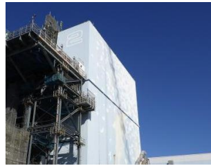
2号機原子炉建屋 点検写真例(南側)
