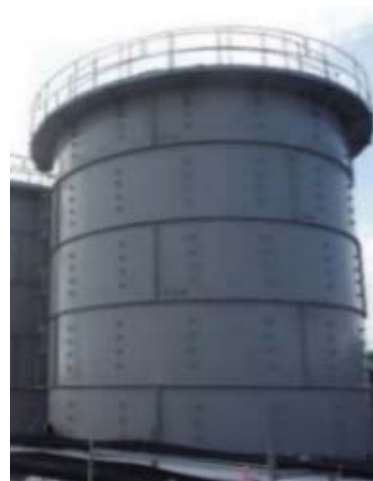
フランジ型タンク
