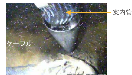
④ケーブルの状況
