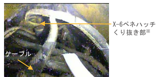
③ケーブル及びくり抜き部の状況
