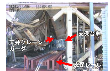
④天井クレーン支保設置作業完了後の状況
