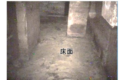
3号機T/Bサービスエリア最下階床面
