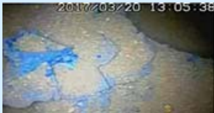
ペDESTAL外側の状況 ※3
