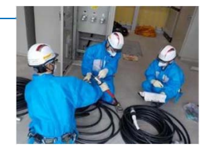
ケーブル導通訓練
