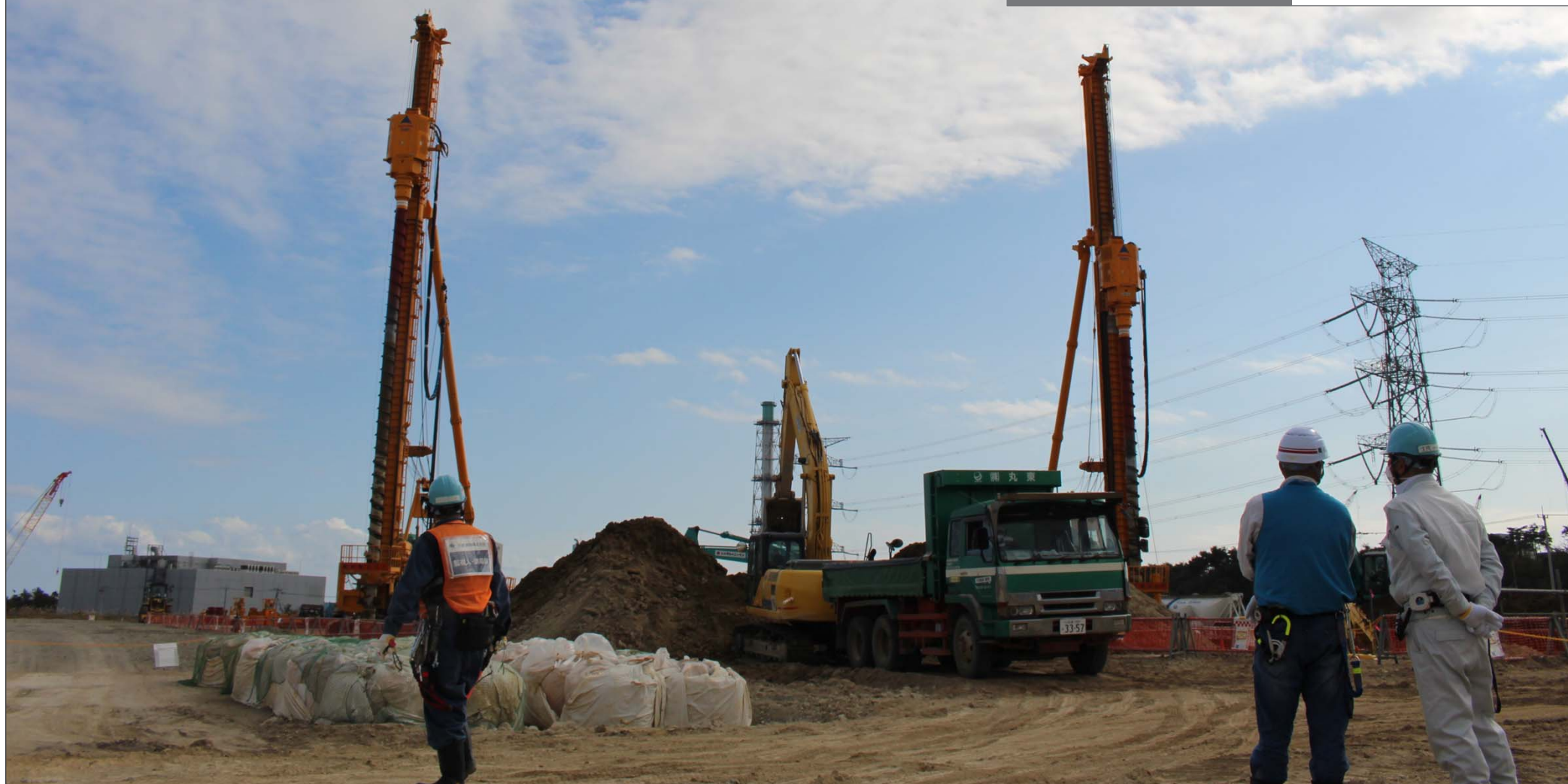
廃棄物関連施設の地盤掘削の様子
