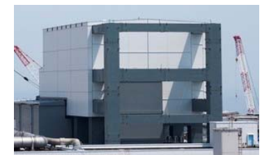
原子炉建屋外観
