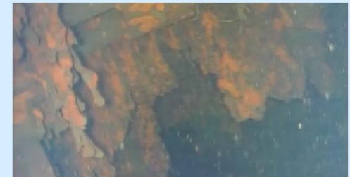
ペDESTAL内側の状況 ※3
