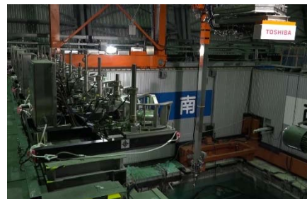
原子炉建屋オペレーティングフロアの様子
