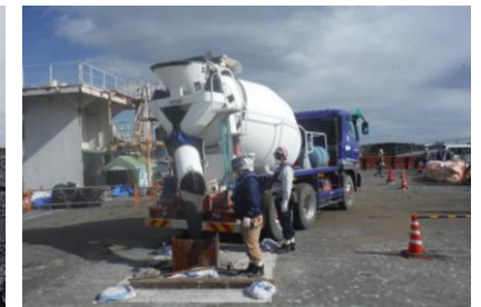
内部充填作業中
