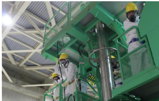
共用プールにおける作業の状況
