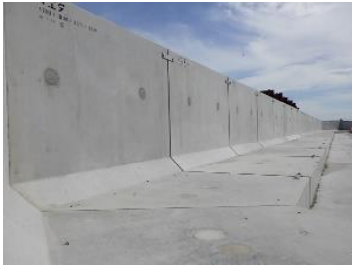
千島海溝津波防潮堤
