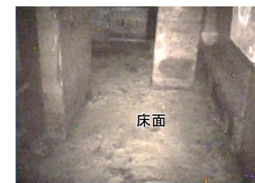
3号機T/Bサービスエリア最下階床面
