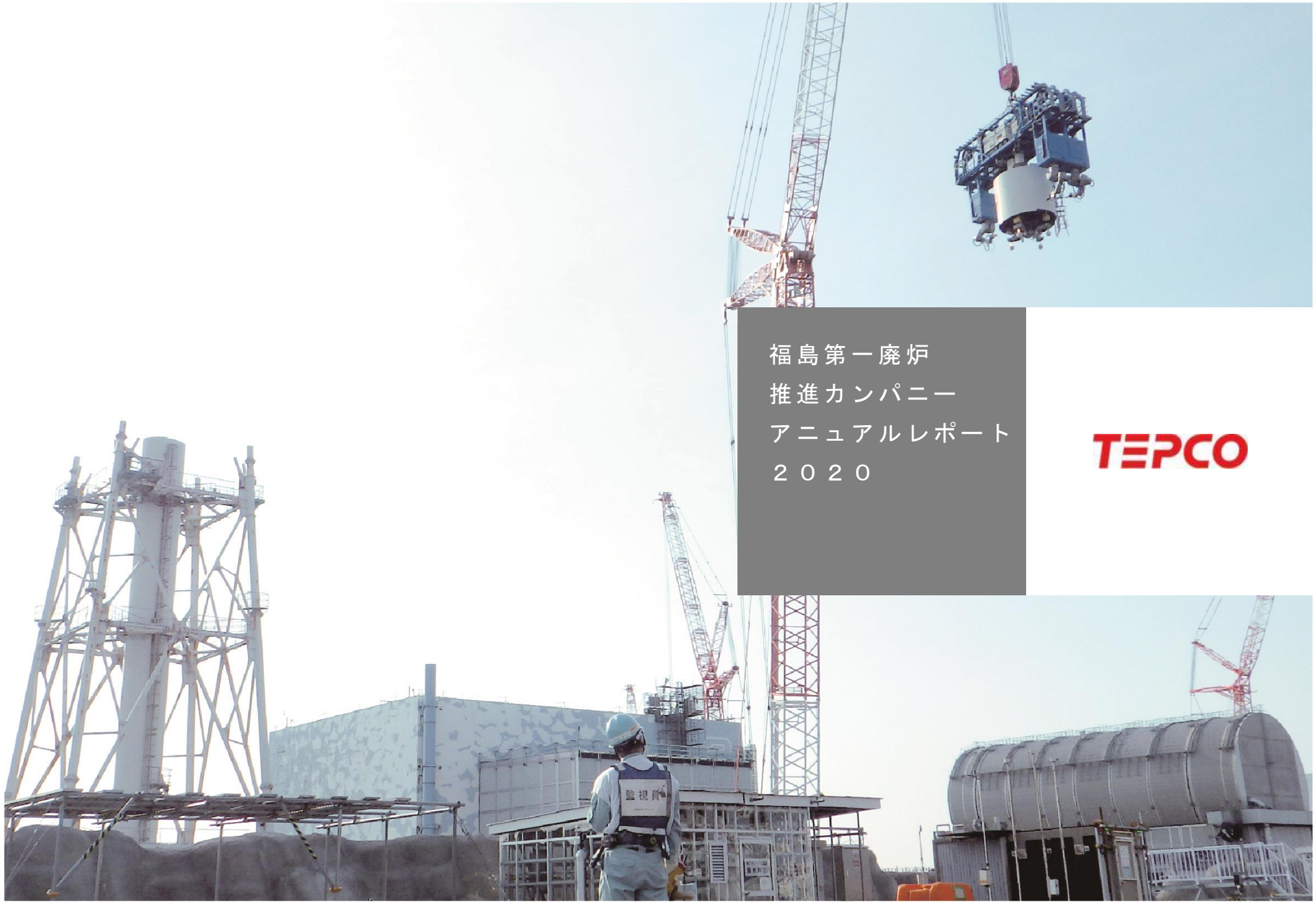
1・2号機排気筒の解体工事
