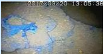
ペDESTAL外側の状況
