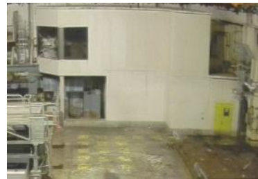
原子炉建屋オペレーティングフロア 南西残置物搬出後の状況
