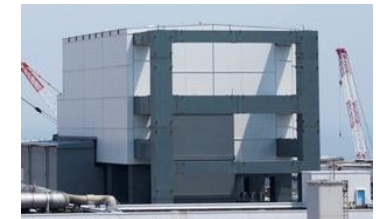
4号機原子炉建屋外観
