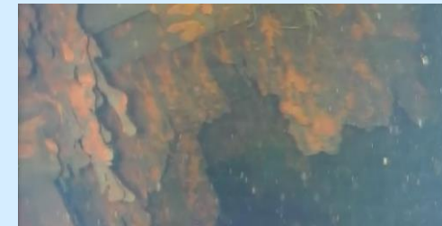
ペDESTAL内側の状況
