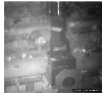
3号機での燃料の吊り上げ（566体目）
