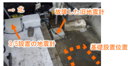
1階地震計移設前
