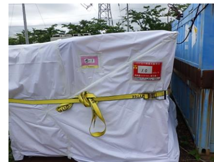
応急処置の例：コンテナ養生・線量表示実施後
