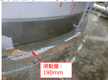
タンク滑動および防水塗装（ポリウレア）損傷（D2タンク） （堰内は少量の雨水が滞留）
