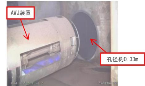
孔径約0.33m孔の貫通状況
