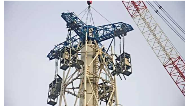
8ブロック目鉄塔解体作業(1月15日)
