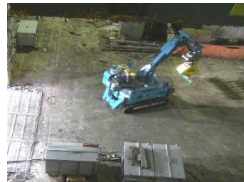
オペレーティングフロア残置物移動状況
