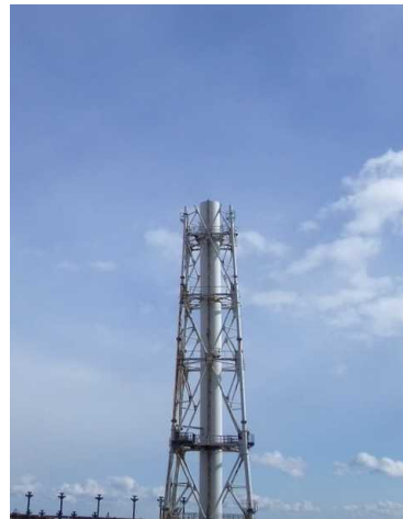
11ブロック解体後 (2020年2月4日撮影)
