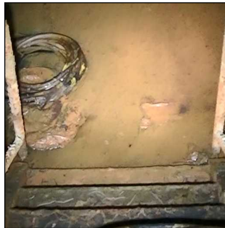
4号機タービン建屋地下1階の 床面露出状況
