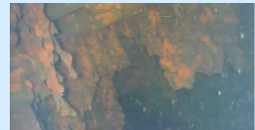
ペDESTAL内側の状況
