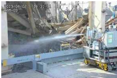
局所散水状況
