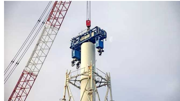
9ブロック目筒身解体作業(1月16日)
