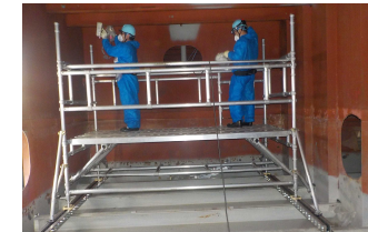
内部除染状況
