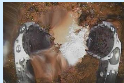
ペDESTAL内堆積物の把持状況
