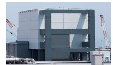
4号機原子炉建屋外観
