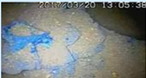
ペDESTAL外側の状況
