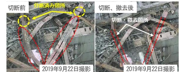
屋根鉄骨切断状況
