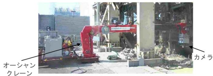
※パンチルト機能付き水中カメラ：左右方向（パン）・上下方向（チルト）の撮影ができる水中カメラ。
