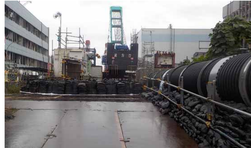
大型土嚢設置状況
