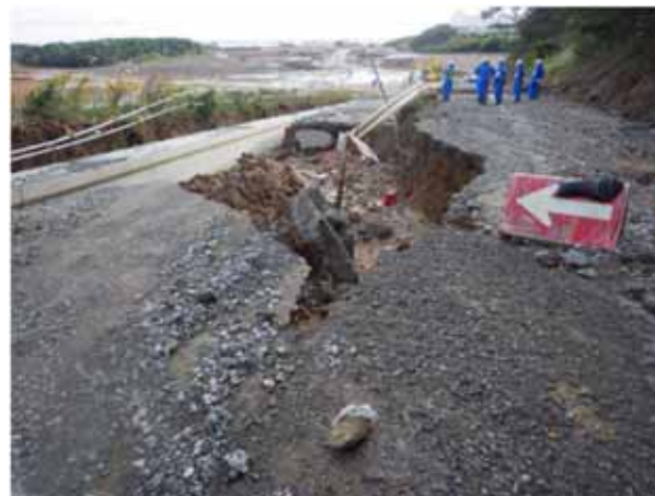
①第二土捨場北構内道路
