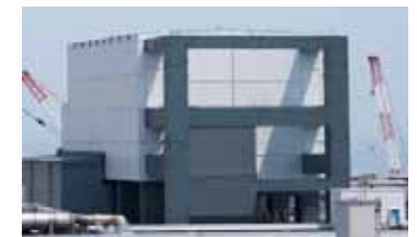
4号機原子炉建屋外観
