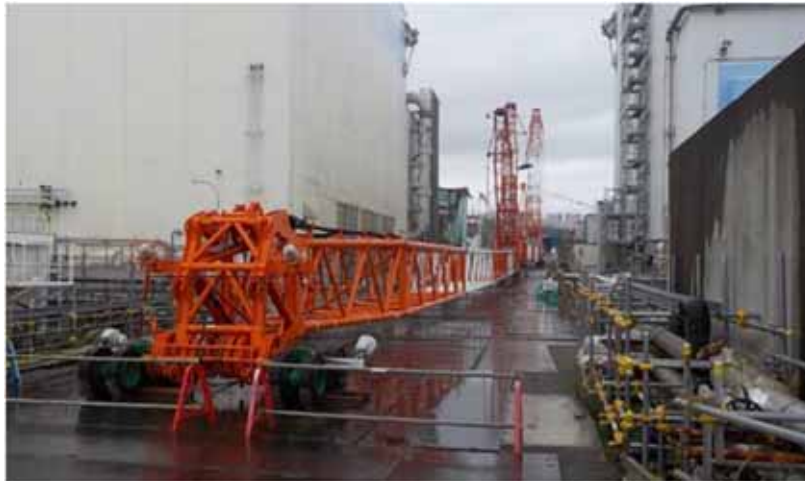
クレーンのブーム伏せ状況
