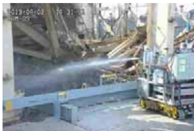
飛散防止剤局所散水状況
