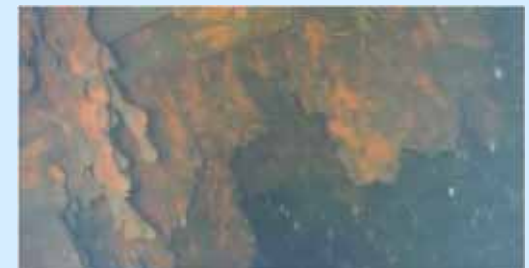
ペDESTAL内側の状況
