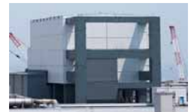
4号機原子炉建屋外観
