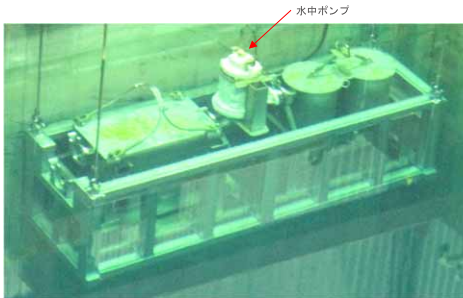
がれき撤去装置
