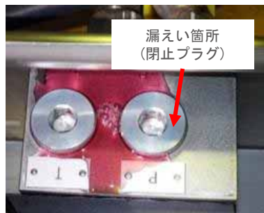
漏えい箇所特定状況
