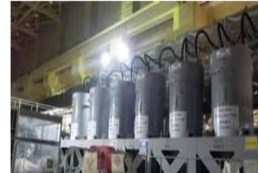
第三セシウム吸着装置 ろ過フィルタ及び吸着塔
