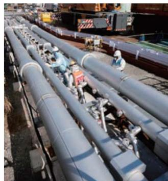
原子炉建屋内への地下水流入を低減させ、汚染水増加を抑制するため、土を凍らせて地下水を遮水する陸側遮水壁の準備工事を2013年11月より開始。2016年3月より凍結を開始。
