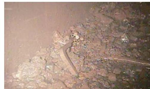
1～3号機における原子炉格納容器の内部調査を実施する中で、2号機で燃料デブリと思われる堆積物を確認。
