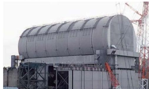
使用済燃料プールの燃料を取り出すため、クレーン設備や、放射性物質の飛散を防ぐためのカバーを設置。
