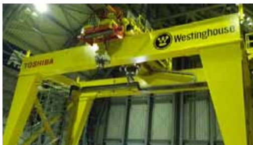
クレーン全景
