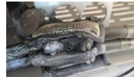
ブレーキレジスタ内の損傷（5月12日）
