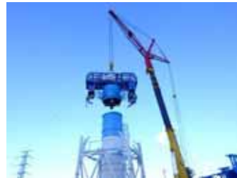
解体部材揚重状況
