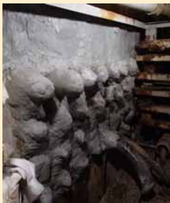
1号機共通配管トレンチ貫通箇所 止水状況
