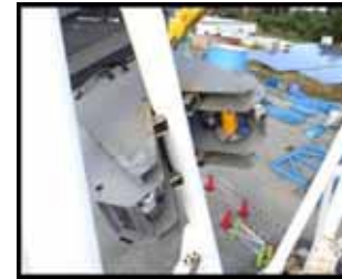
斜材切断装置切断状況
