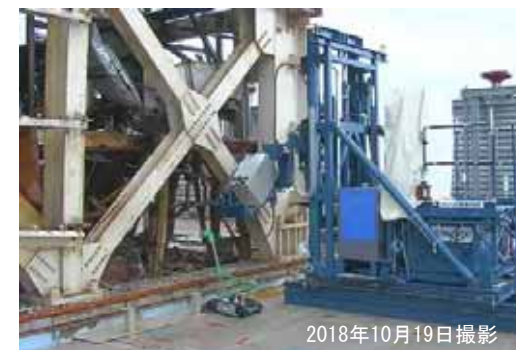
Xブレース撤去の状況写真(南面)
