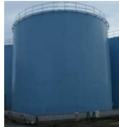
溶接型タンク
