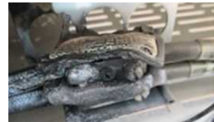
ブレーキレジスタ内の損傷（5月12日）
