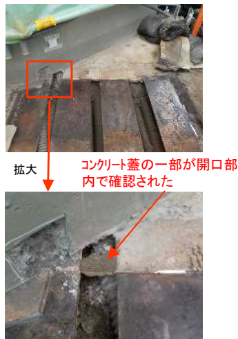
< 4-2. 開口部の状況 >
