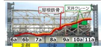
6a 6b 7a 8a 9a 10a 11a 北側 中央 南側 ※：格納容器上に被せるコンクリート製の蓋 <1-5. オペレーティングフロア上南側瓦礫の状況>
