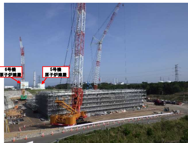
<1-29. 工事全景（敷地北西より南東方向を見る）>
