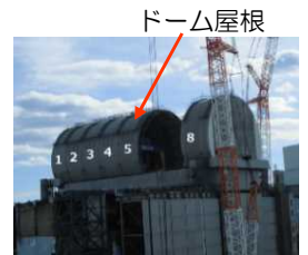
<1-26. ドーム屋根設置状況>
