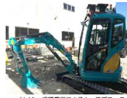
<1-15. 遠隔重機によるルーフブロック撤去イメージ>
