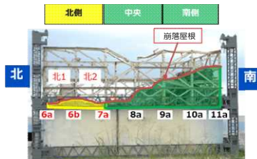
北側瓦礫撤去範囲（今回） 中央・南側瓦礫撤去範囲（今後計画）
