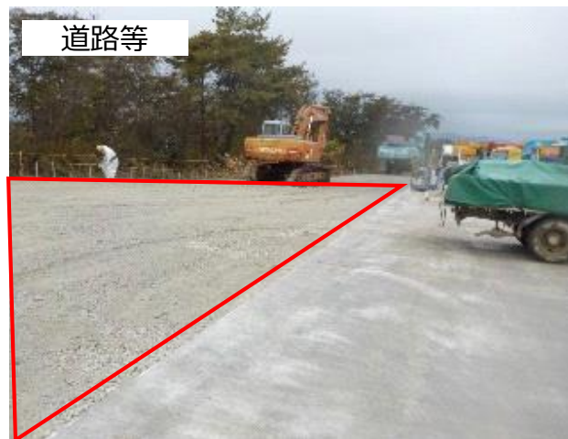
図 1F構内におけるコンクリートガラ再利用の例
