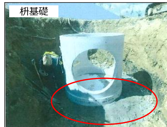
図 1F構内におけるコンクリートガラ再利用の例
