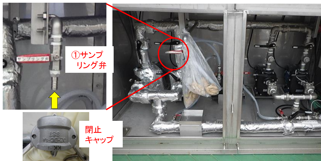
サンプリング弁（左上）と閉止キャップ（左下）
