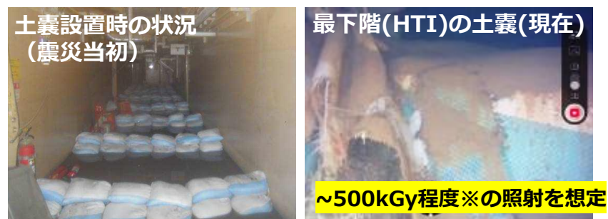
ゼオライト土嚢袋の現場状況
