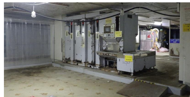
補機設置予定エリア付近
