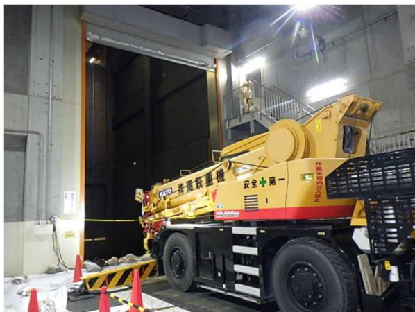
ラフタークレーン配置
