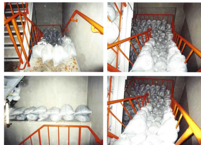
活性炭の状況（設置時）
