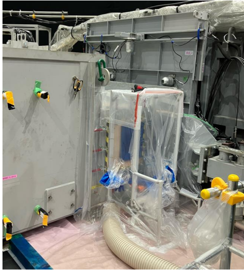
側面ハウス設置
