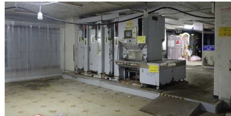
補機設置予定エリア付近
