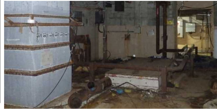
中央開口部付近（容器封入作業用ROV投入箇所）
