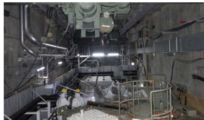
開口部付近（容器封入作業用ROV投入箇所）
