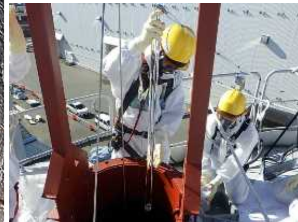
攪拌実証試験当日の採水の様子
