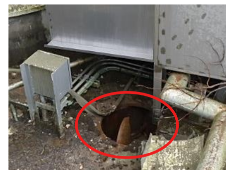
サンプ南東部のマンホール
