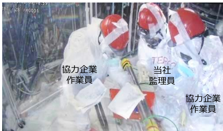
押し込みパイプの復旧作業（現場確認状況）
