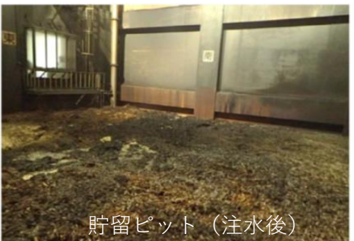
廃棄物供給室全景
