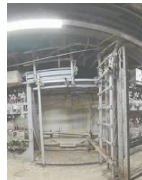
4号機南側シエル壁 撮影状況
