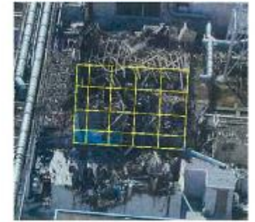
図-4.1 3号機原子炉建屋の損傷状況（立面図）
