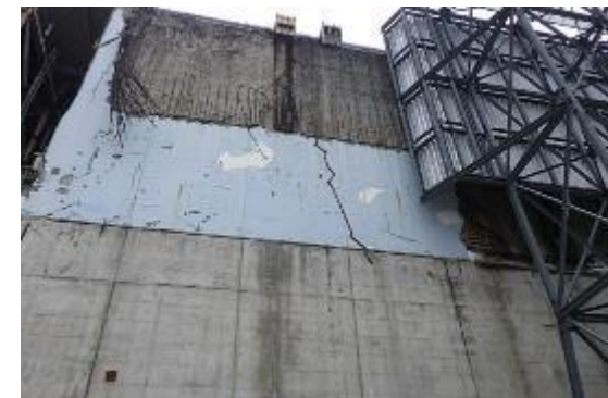
3号機原子炉建屋北側外壁
