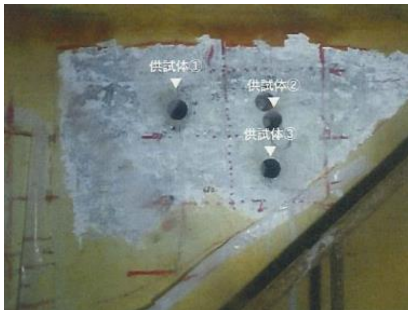
地下階のコア採取状況
