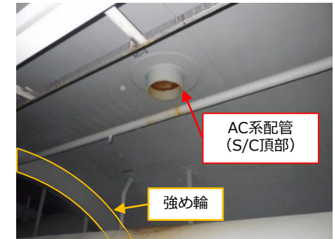
(参考) 5号機AC系配管のS/C突き出し状況
