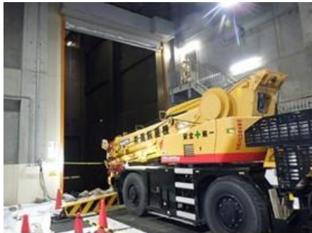
ラフタークレーン配置
