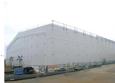
多核種除去設備（ALPS）
