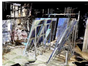
北西外壁点群
