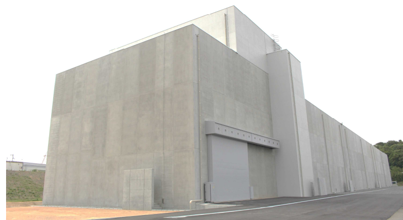
屋内保管 大型廃棄物保管庫
