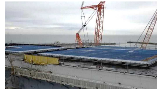
3号機タービン建屋 損傷部補修
