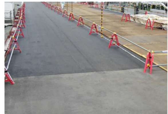
②アスファルト舗装完了 (2023.9)
