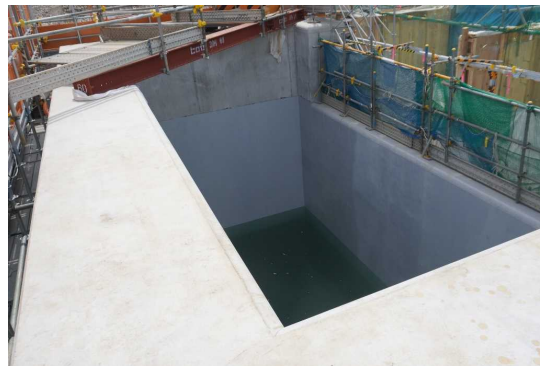
水張り完了後の放水立坑（下流水槽） （2023年6月）
