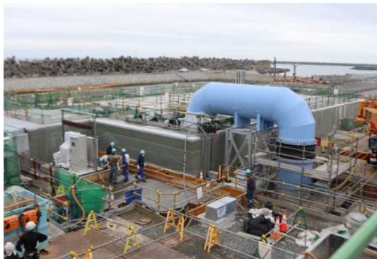
放水立坑（上流水槽）全景 （2023年6月）
