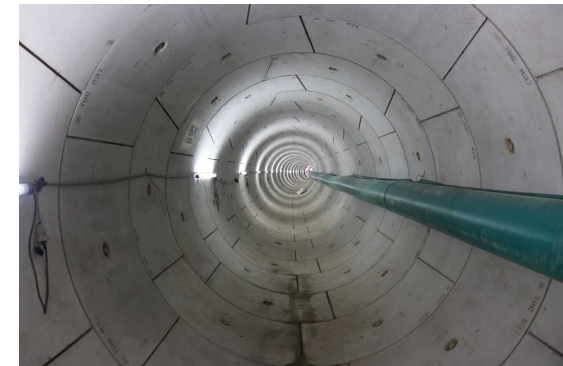
掘進完了後の放水トンネル内（2023年5月）
