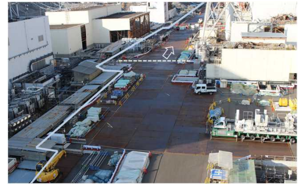
①フェーシング工事完了後 (フェーシング上に鉄板敷設) : 全景 (2024.2)
