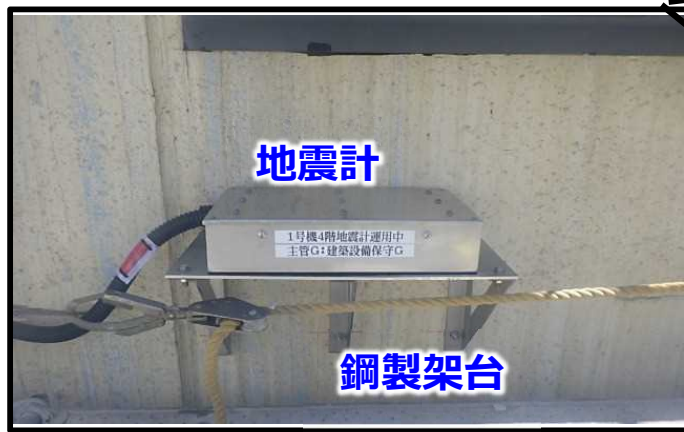
1号機原子炉建屋 4階レベル (西側)
