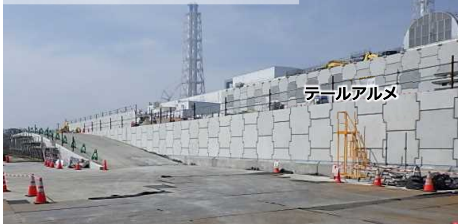
テールアルメ設置状況
