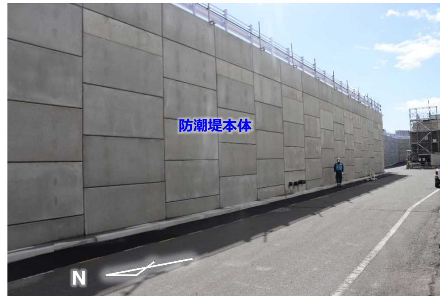
図4-2.4号機南側(プロセス主建屋-海側) 撮影方向③(2024年3月7日撮影)
