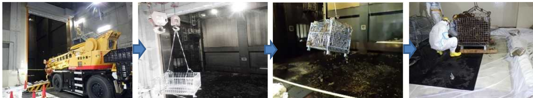
ラフタークレーン配置
