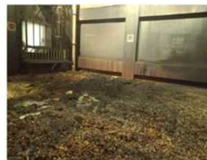
3/7撮影 廃棄物貯留ピット内の状況
