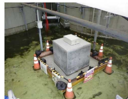
内堰基礎部に設置後
