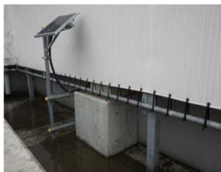
内堰外側に設置時
