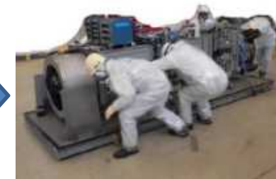
堆積物除去装置 （低圧水）撤去
