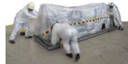
堆積物除去装置 （高圧水、AWJ）撤去
