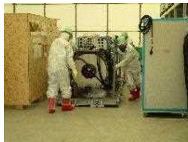
堆積物除去装置 （高圧水、AWJ）設置
