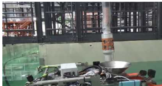
移送ホース (地下階接続作業)
