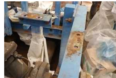
サポート部（配管取外後）
