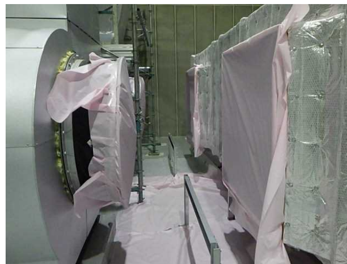
既設ダンパ・ダクト取り外し (10/9)
