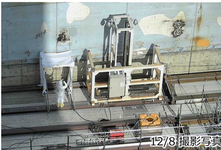
高圧洗浄の状況
