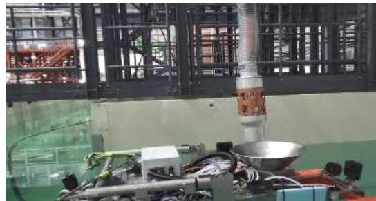
移送ホース (地下階接続作業)
