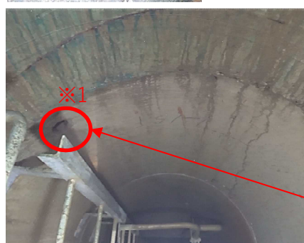
水面はマンホール上部から5m以上、下部にある（目測）
