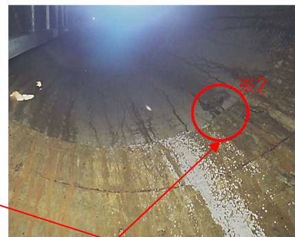
マンホール上部より約1 m下に穴を確認
